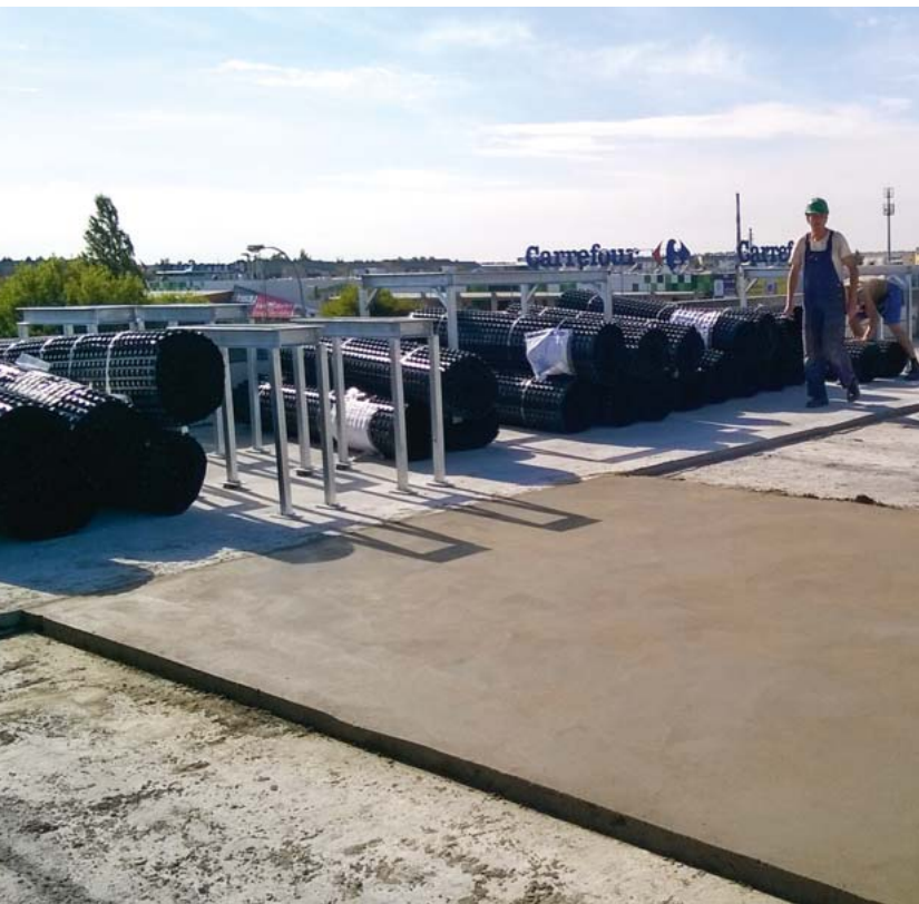
Prace na dachu płaskim w Białymstoku. Fot. P.P.H.U. Marcin Bieliński
