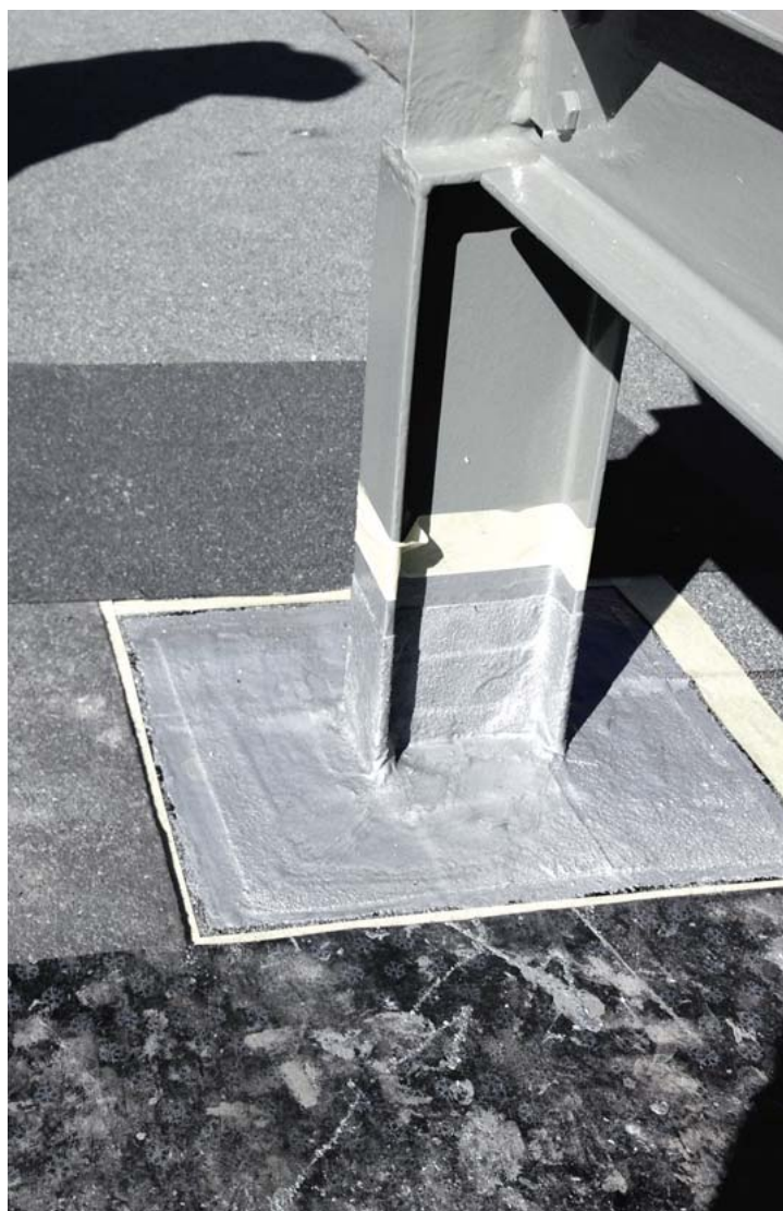
Doszczelnienie słupków na dachu płaskim. Wykonano uszczelnienie z płynnych folii. Dodatkowo powierzchnię wykończono posypką w kolorze papy ze wględów estetycznych. Fot. DAFA
